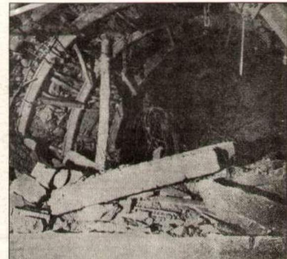
Mur écroulé. Il devait barrer l'accès de Bd 306 (qui conduisait aux anciens travaux) et empêcher la sortie du grisou. Il n'était qu'en construction le jour de l'accident.
