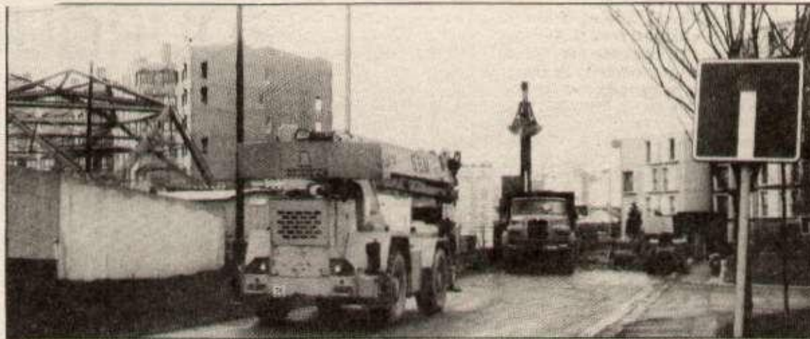
Villeneuve-d'Ascq : une ville en chantier.
