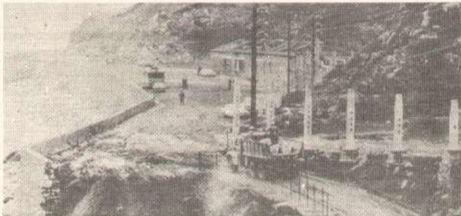
Flamanville : rassemblement ce week-end. Ci-contre gardé par les CRS, le chantier de la centrale nucléaire. Mais la lutte contre l'implantation continue : le comité régional anti-nucléaire organise un rassemblement samedi et dimanche.
