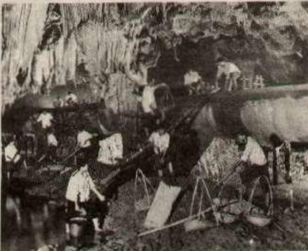
Des membres de commune du district autonome Yao de Touan, construisant un aqueduc à l'intérieur d'une grotte.
