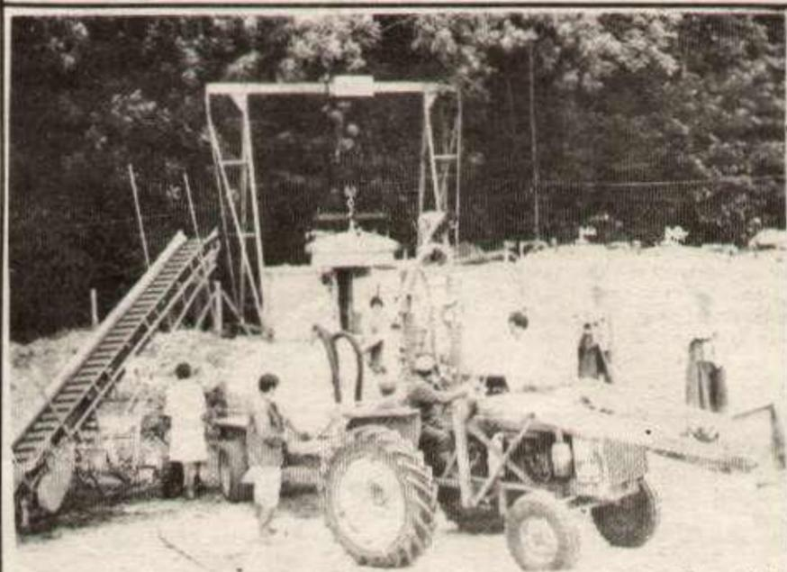
Digesteur mis en place à l'INRA pour l'étude de la fermentation méthanique. (Photo INRA)
