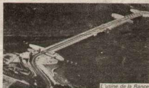
L'usine de la Rance
