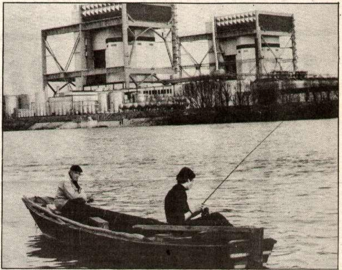
Le choix de construire des grosses unités productrices uniquement d'électricité (ici St Laurent des Eaux) implique nécessairement que 60 % de leur énergie est gaspillée, et va réchauffer fleuves et rivières.
