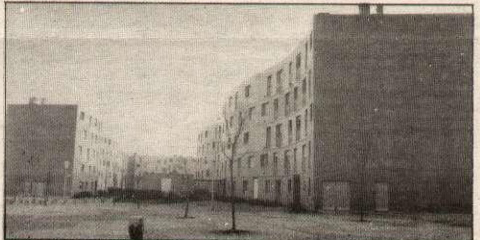
La Grande-Borne à Grigny : des logements qui prennent l'eau.
