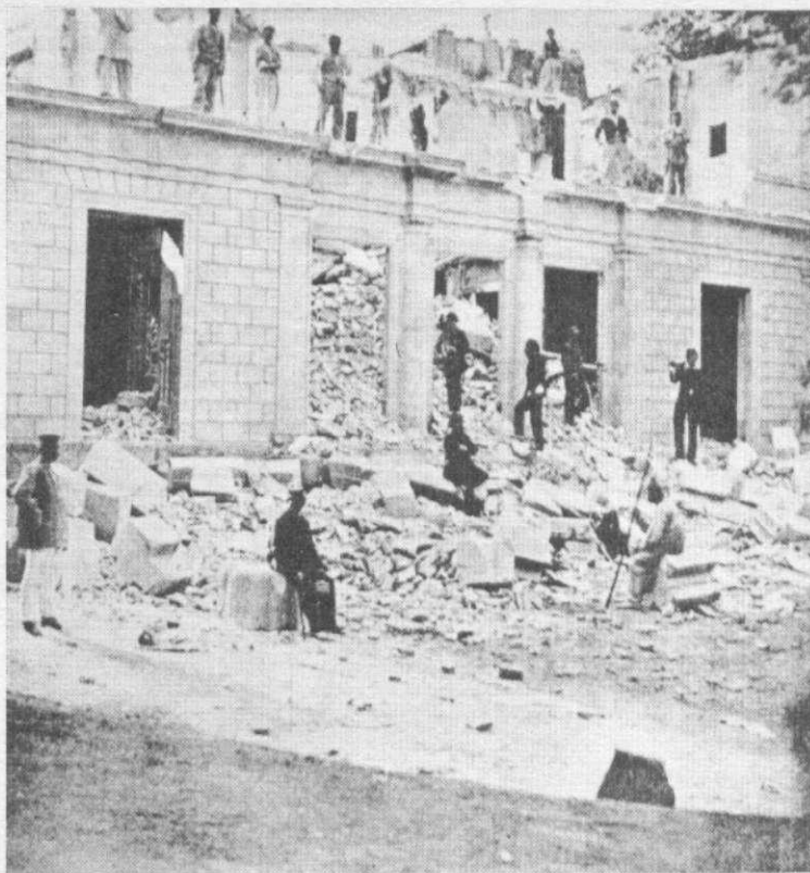
Destruction de la maison de Thiers.
