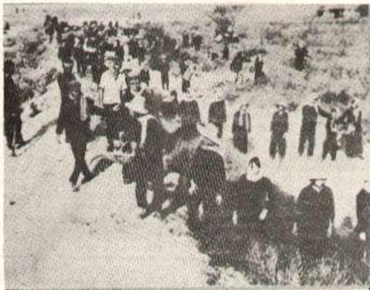
Les paysans cambodgiens construisent une digue à Kratié.
