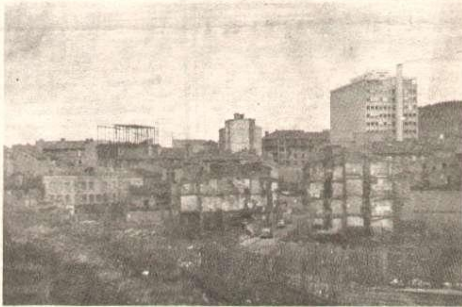
Le quartier Beaubrun voué aux pioches des démolisseurs.
