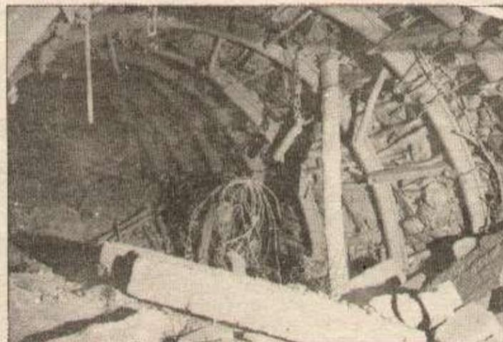
Un mur écroulé à la suite de l'explosion. Il devait barrer un accès et empêcher la sortie du grisou... Il n'était qu'en construction le jour de l'accident !
