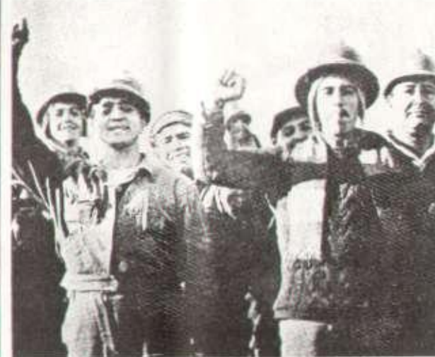
Mobilisation des ouvriers.
